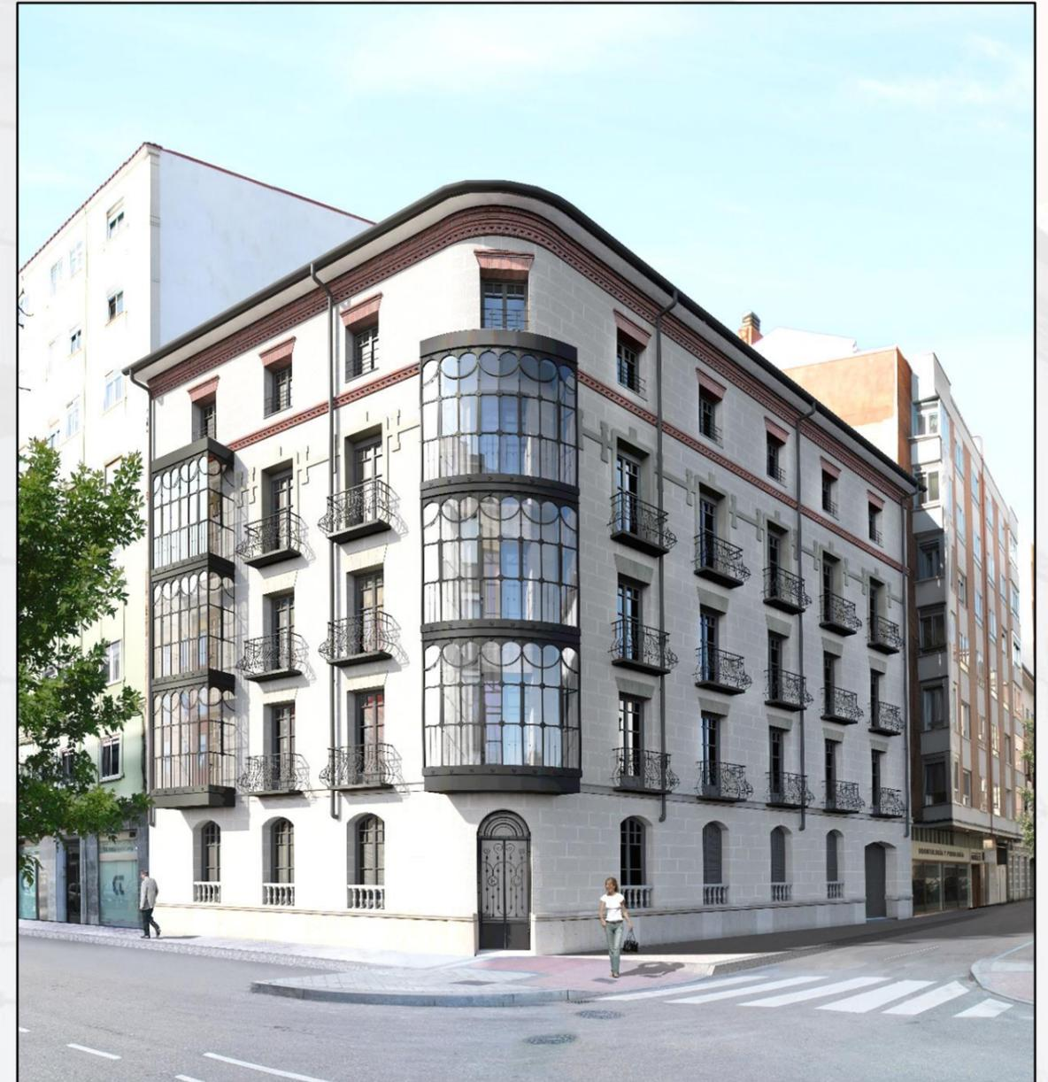
Recuperación de zócalo con aplacado con piedra natural con moldura y encuentro de remate y balaustrada a juego en ventanas de planta baja.
