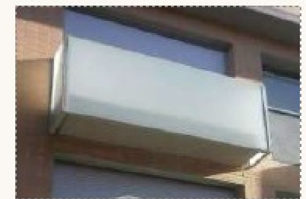
Balcones vidrio translúcido
