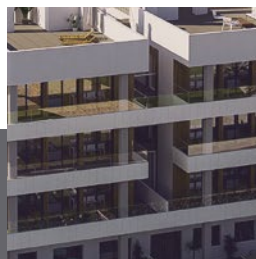
Carpintería de PVC de color combinado con la fachada
